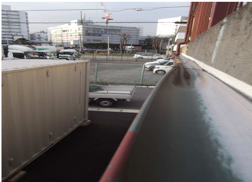
1F軒樋・歪 み破損
