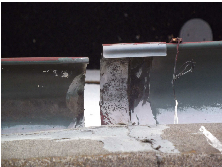
軒樋割れ・ 外れ ..... ..... ..... ..... ..... ..... ..... ..... ..... .....
