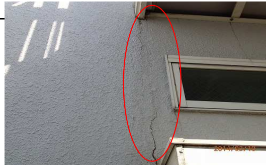
バルコニー下とシャッターボックス上部の クラックがつながっています
